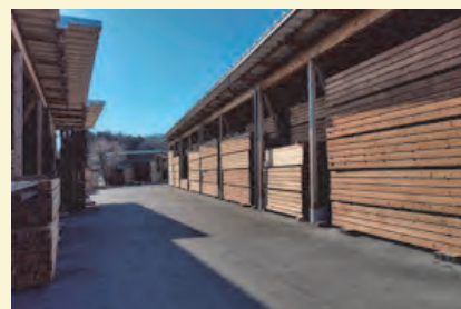
国産横架材の生産強化に資する半製品保管庫
