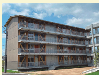
構造材が現しで用いられている県営住宅の外観
