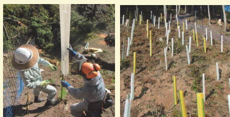
〈保護資材の設置状況〉
