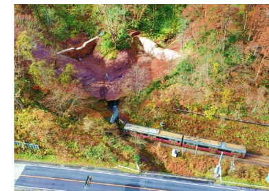
峠の沢における施工箇所及び保全対象
