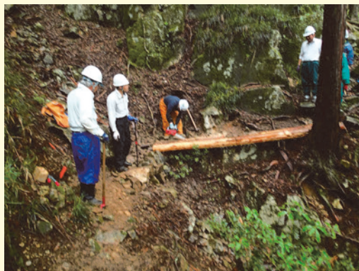
丸太橋架替えの様子
