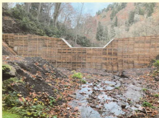
令和 4 (2022)年11月に完成した直後の状況 (No.1治山ダム上流側)
