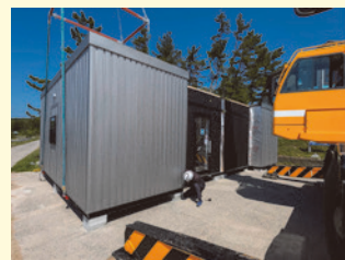
左：志賀町でのCLTセルユニット設置 右：CLTセルユニットの内装
