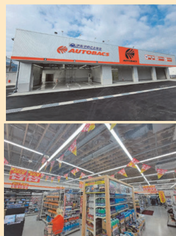
オートバックス四国中央店 株式会社オートバックスセブン (愛媛県四国中央市、令和6(2024)年竣工)
