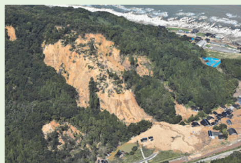
地震及び大雨による崩壊斜面からの土砂流出 (石川県珠洲市)
