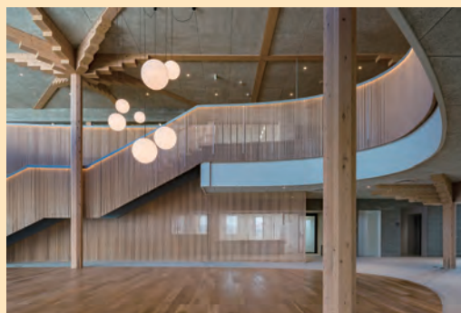
みやぎ登米農業協同組合本店・東部なかだ基幹支店 (宮城県登米市、令和5(2023)年3月竣工) 束ね柱・重ね梁・重ね肘木による架構で、一般的なサイズのスギ製材を用いて大スパンかつ意匠性の高い空間を実現した事務所
