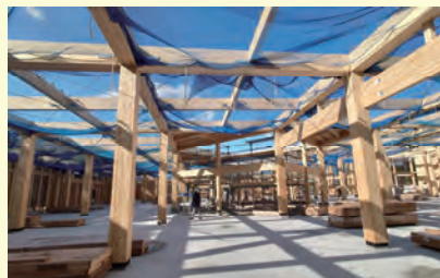
木造店舗の建設の様子
