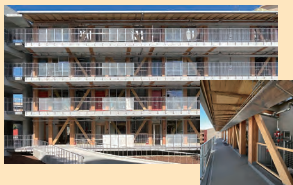
徳島県新浜町団地県営住宅2号棟
