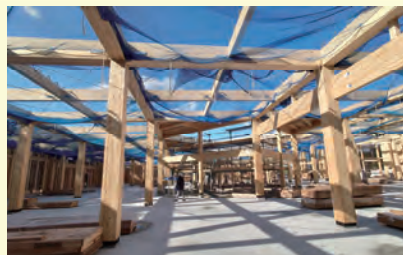
木造店舗の建設の様子
