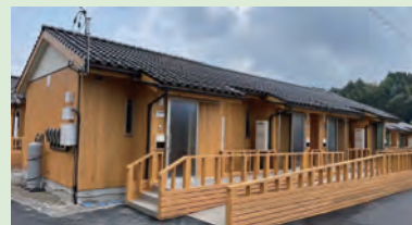
木造応急仮設住宅(長屋型)
