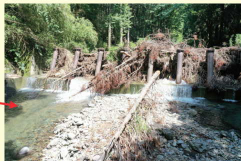
治山ダムによる流木の捕捉状況(熊本県高森町)
