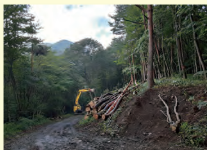
自然林への転換作業
