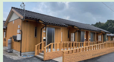
木造応急仮設住宅(長屋型)
