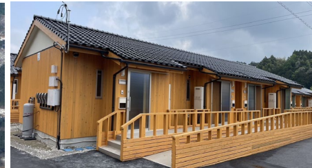
木造応急仮設住宅（長屋型）
