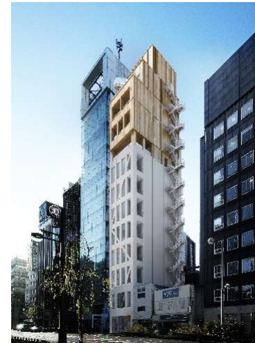
銀座高木ビル (東京都中央区)
