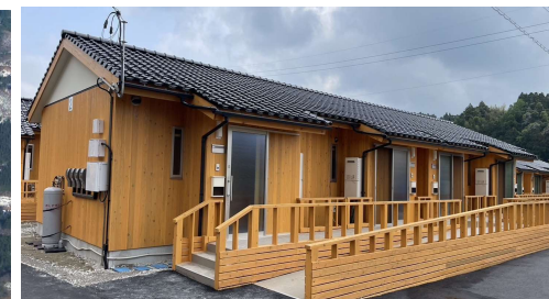
木造応急仮設住宅（長屋型）
