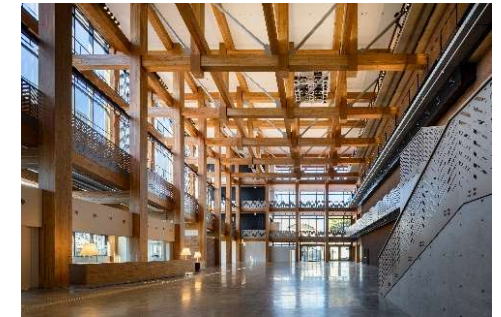
水戸市民会館 (茨城県水戸市)
