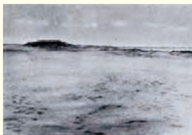
着手前の荒廃状況 (明治43(1910)年)
