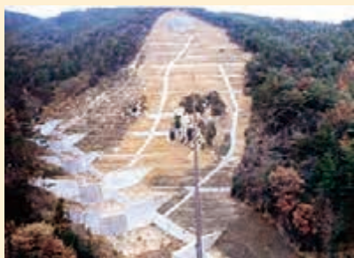
施工中(昭和55(1980)年)
