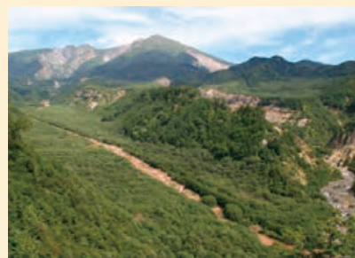
施工後27年(平成25(2013)年)
