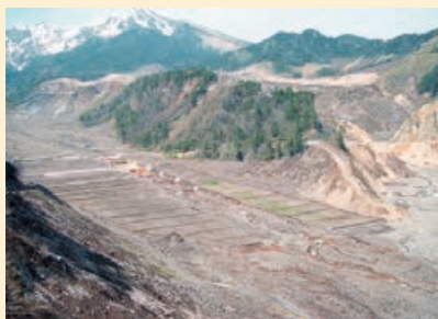
施工中(昭和61(1986)年)
