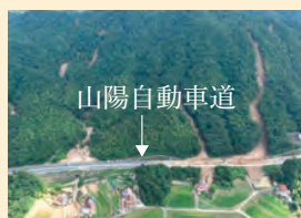
「平成30年7月豪雨」による荒廃状況
