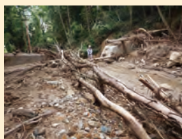
治山ダムにより土砂・流木の流出を抑制
