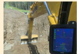
ICTバックホウによる施工
