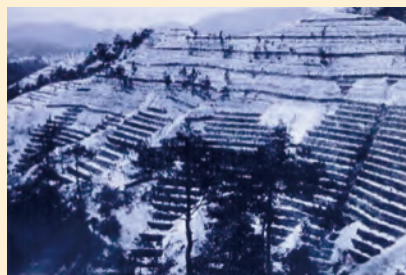
山腹工の施工(大正6(1917)年)
