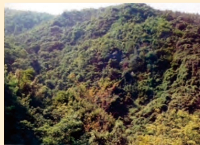
施工後19年(平成11(1999)年)
