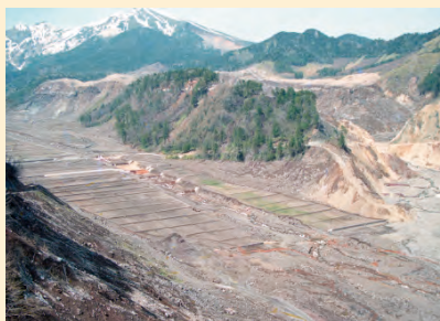
施工中(昭和61(1986)年)
