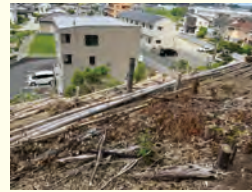
<整備後の状況>
