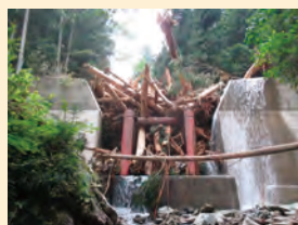
流木捕捉式治山ダムの 整備
