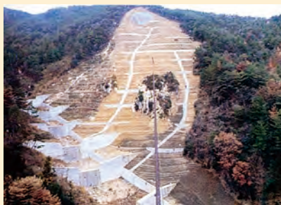
施工中(昭和55(1980)年)
