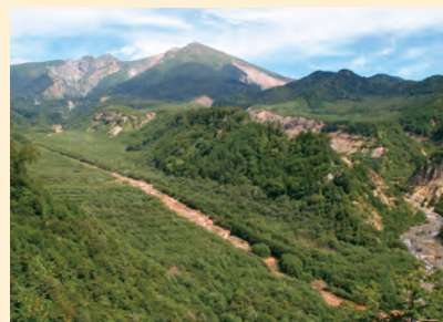
施工後27年(平成25(2013)年)
