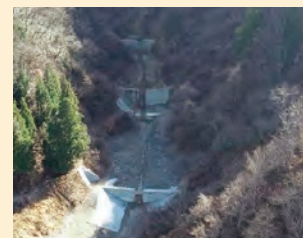
小規模な治山ダムを 階段状に配置
