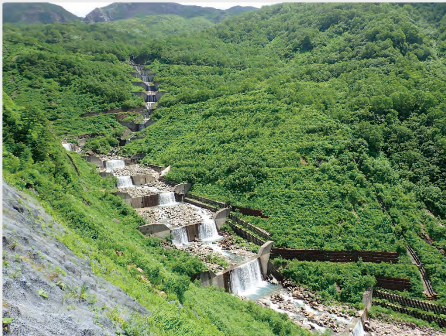
施工後約30年が経過し植生に覆われた手取川地区民有林直轄治山事業実施箇所 (石川県白山市)
