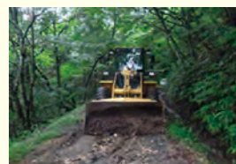
8月18日 林道の補修
