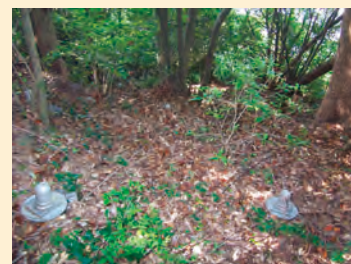
斜面補強土工 (地山補強土工)
