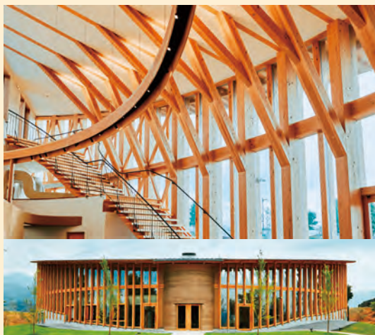
OYAKI FARM BY IROHADO (長野県長野市、令和4(2022)年7月竣工) 構造材、仕上げ材共に長野県産のスギ・ヒノキ製材を 使用した工場兼販売施設
