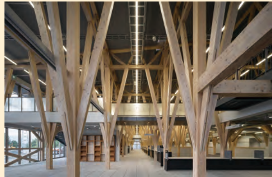
茨城県大子町庁舎 (茨城県大子町、令和4(2022)年7月竣工) 茨城県産材による構造を現しにした 準耐火建築物
