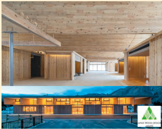
みなみあいづ森と木の情報・活動ステーション 「きとね」 (福島県南会津町、令和4(2022)年3月竣工) 地元産製材の重ね梁や縦ログによる木造2階建て (写真提供：南会津町)
