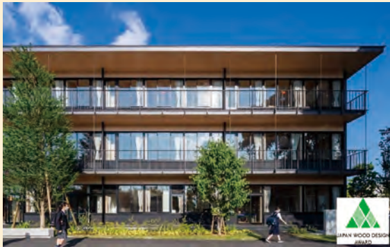
流山市立おおぐろの森中学校 (千葉県流山市、令和4(2022)年3月竣工) LVL、CLT、製材等を組み合わせて鉄筋コンクリート 造と同等のコストで実現した木造校舎 (写真提供：株式会社川澄・小林研二写真事務所)
