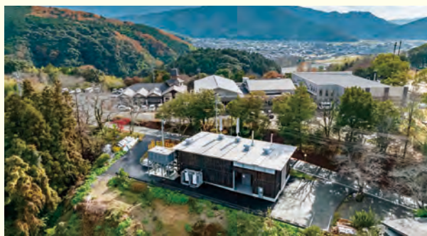
木質バイオマス発電所(手前)と熱利用を行っているスポーツ施設(奥)
