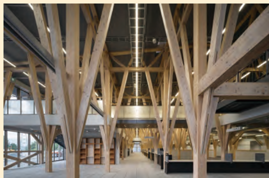
茨城県大子町庁舎 (茨城県大子町、令和4(2022)年7月竣工) 茨城県産材による構造を現しにした 準耐火建築物
