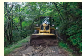
8月18日 林道の補修
