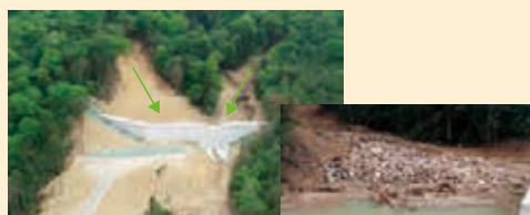
令和3(2021)年8月の大雨における治山ダムによる土砂の流出抑制
