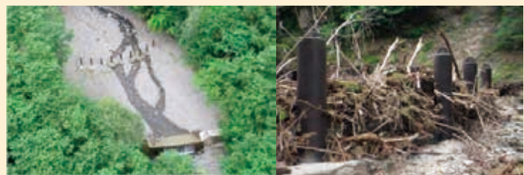
既設治山ダムの堆砂域に鋼管を設置し、流木捕捉機能を付加(岐阜県恵那市、東濃森林管理署)
