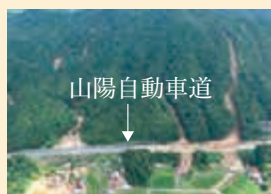
「平成30年7月豪雨」による荒廃状況
