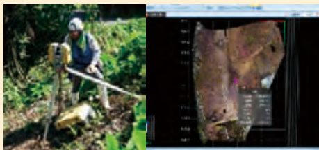
3Dレーザスキャナによる測量
