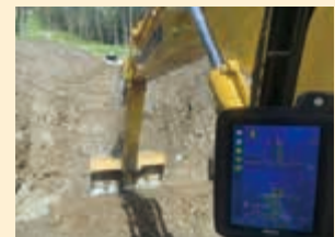
ICTバックホウによる施工
