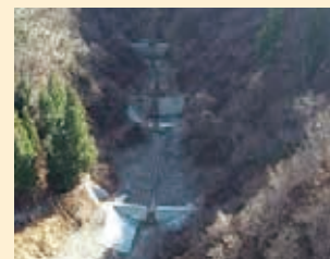
小規模な治山ダムを 階段状に配置
