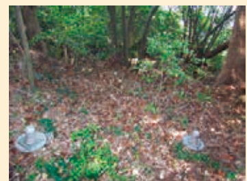
斜面補強土工 (地山補強土工)
