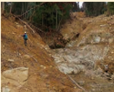
平成30年7月豪雨(広島県東広島市) 溪流の縦侵食 3~5 m
