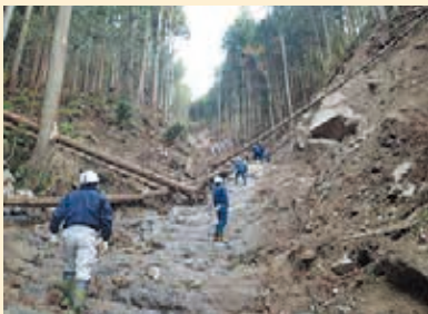
令和元年東日本台風(宮城県丸森町) 溪流の縦侵食 2~3 m
