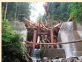
流木捕捉式治山ダムの 整備
