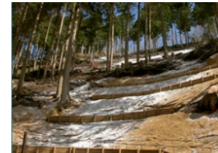
柵工による斜面補強対策
