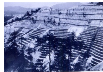
山腹工の施工 (1917年)
