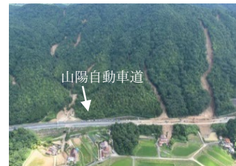
「平成30年7月豪雨」による荒廃状況
