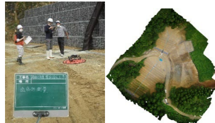
地上からの測量が困難な箇所等で実施
