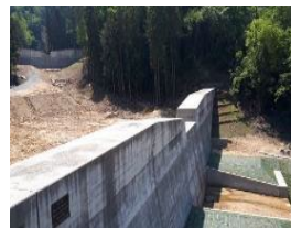
土石流の衝撃に対応する断面の厚い治山ダム
