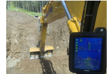
マシンガイダンス機能により正確な掘削ができるため、手戻りリスクを軽減
