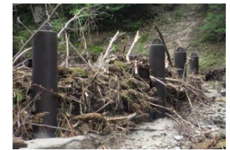
既設治山ダムの堆砂域に鋼管を設置し、流木捕捉機能を付加（岐阜県恵那市 えな 、東濃森林管理署 とうなつ ）
