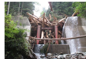
流木捕捉式治山ダムの整備
