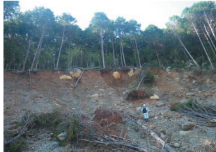
つなぎまち 令和2年7月豪雨 熊本県津奈木町 (崩壊深：約5m)
