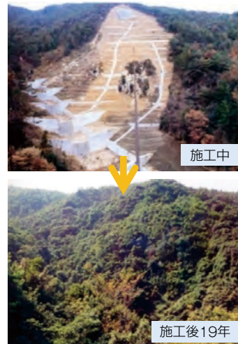
山腹工等による崩壊地の復旧 (香川県小豆島町)
