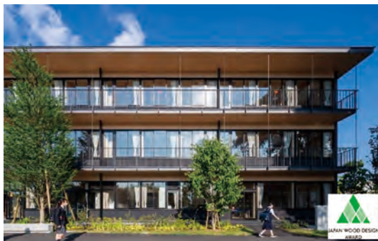
千葉県流山市立おおぐろの森中学校(千葉県流山市) (写真提供: 株式会社川澄・小林研二写真事務所)
