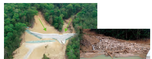
令和3年8月の大雨における治山ダムによる土砂の流出抑制
