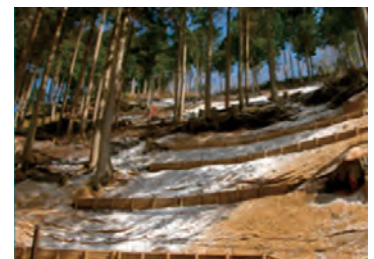
柵工による斜面補強対策
