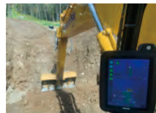
マシンガイダンス機能により正確な掘削ができるため、手戻りリスクを軽減
