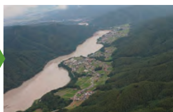
大きな崩壊の発生なし
