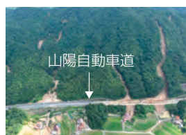
「平成30年7月豪雨」による荒廃状況
