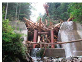
流木捕捉式治山ダムの整備
