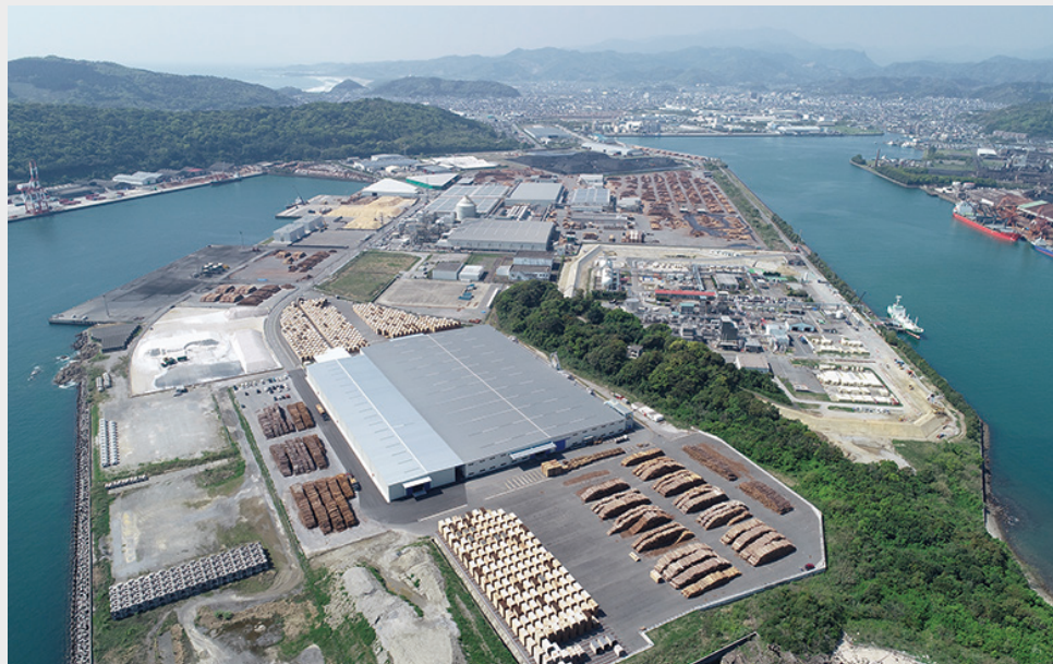
大規模製材工場(宮崎県日向市)
