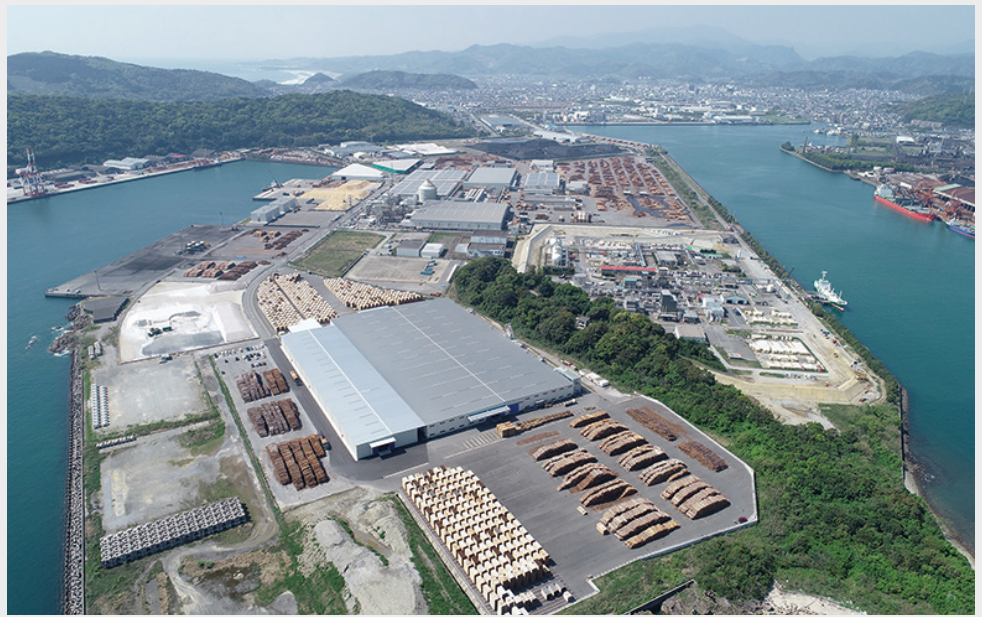
大規模製材工場(宮崎県日向市)
