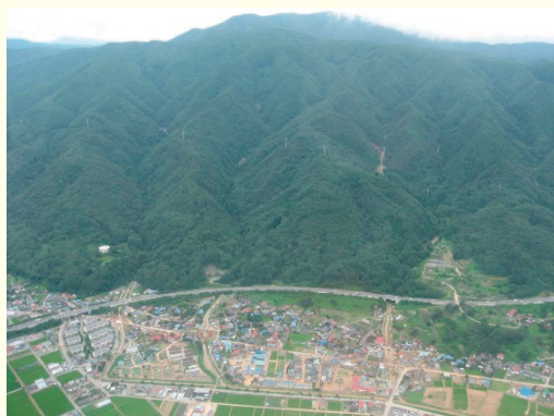
土砂流出防備保安林の全景
