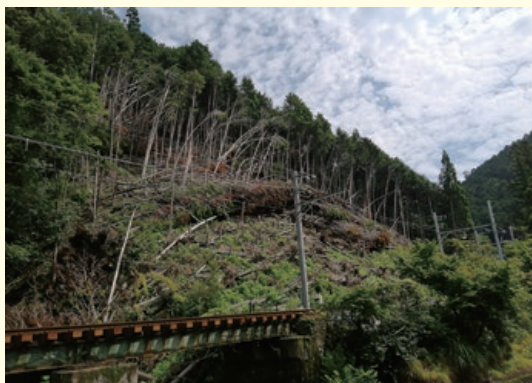
叡山電車線路沿いの被害地(京都市左京区)
