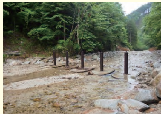
施工地全景(中部森林管理局 ちゅうぶ 東濃森林管理署 (平成30(2018)年施工))
