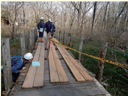
戸隠森林植物園の木道の損傷点検
