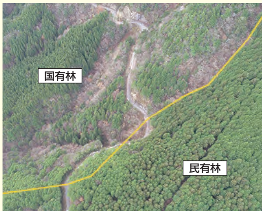
民有林に接続する林業専用道を開設
