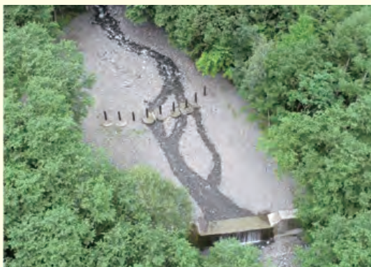
施工地全景(中部森林管理局 ちゅうぶしん 中信森林管理署 (平成30(2018)年施工))
