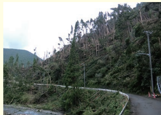
公道沿いの被害地(京都市北区)
