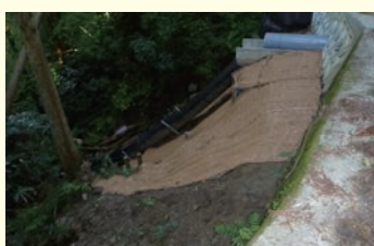
路網の修復状況
