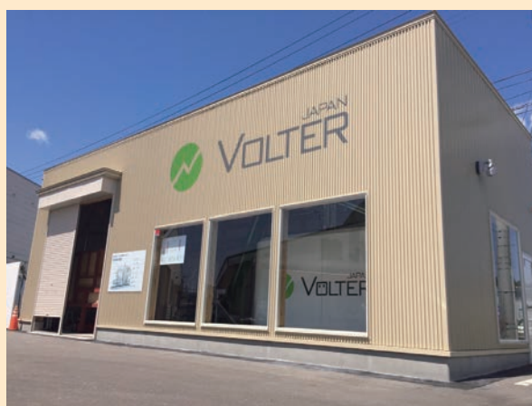
道の駅「たかのす」の発電所（40kW）
