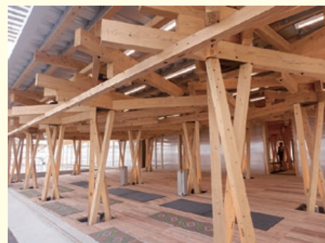
選手村ビレッジプラザ エントランス
