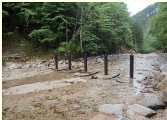
施工地全景（中部森林管理局東濃森林管理署 （平成30（2018）年施工）
