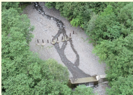
施工地全景（中部森林管理局中信森林管理署 （平成30（2018）年施工）
