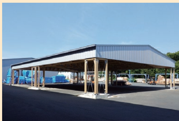
三井ホームコンポーネント株式会社「スマート倉庫」
