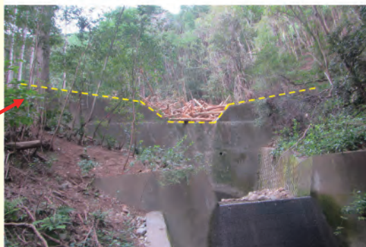
治山ダム(昭和62(1987)年度施工)による流木の流出等の抑制効果(三重県紀北町)
