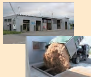
木質チップボイラー への搬入
