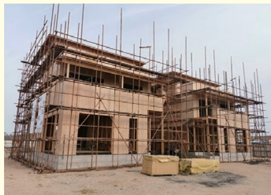
建設中の木造軸組住宅(中国・大連)
