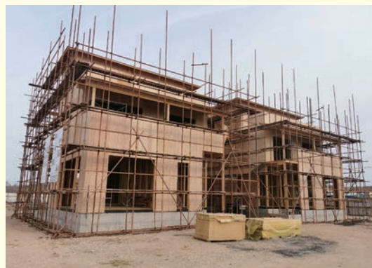
建設中の木造軸組住宅(中国・大連)
