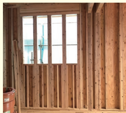
施工事例（市川ホームギャラリー）
