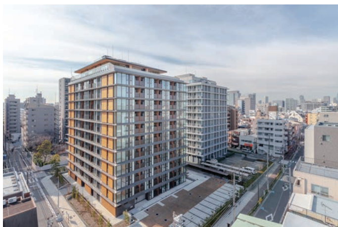
建物の一部を木造化した12階建て共同住宅 「FLATS WOODS 木場」(東京都江東区) (写真提供:株式会社竹中工務店 設計部)
