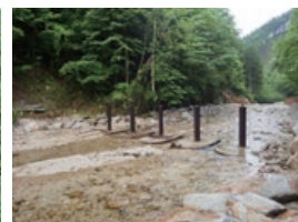
施工地全景(中部森林管理局 東濃森林管理署(2018 年施工))
