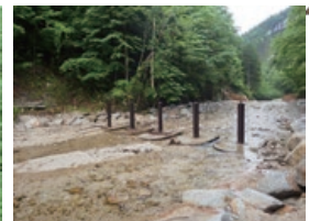
施工地全景(中部森林管理局 東濃森林管理署(2018年施工))
