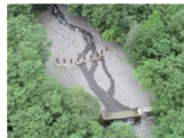
施工地全景(中部森林管理局 中信森林管理署(2018年施工))
