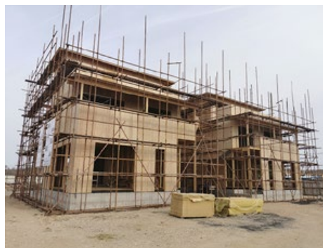
中国の大連で建設中の木造軸組住宅
