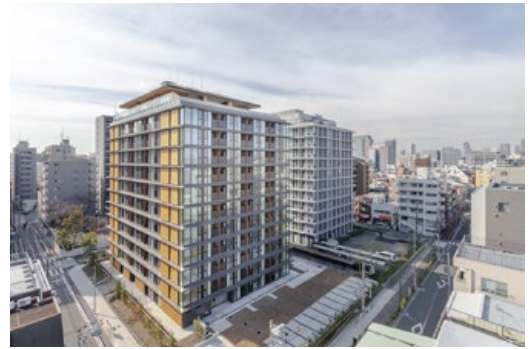
建物の一部を木造化した12階建て共同住宅 (東京都江東区) (写真提供：(株)竹中工務店 設計部)
