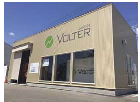
小型バイオマス発電所(40kW)
