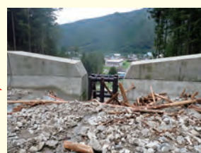
治山ダム(平成29(2017)、30(2018)年度施工)による流木の流出等の抑制効果(岐阜県下呂市)
