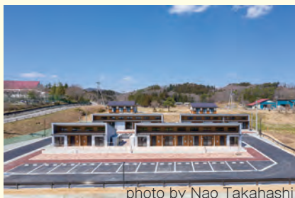
photo by Nao Takahashi 大師堂住宅団地の木造災害公営住宅
