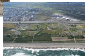
海岸防災林の植栽完了後 (2020年10月撮影)
