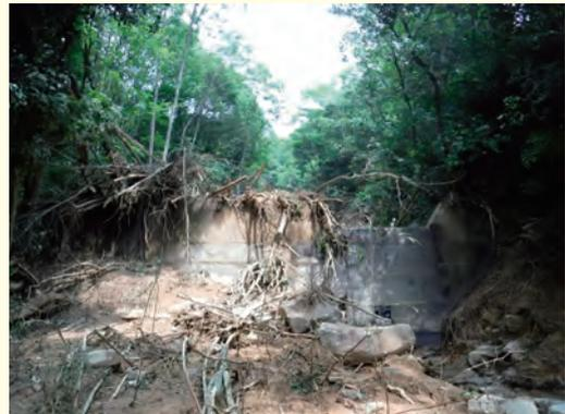
治山ダム(昭和42年度施工)による流木の流出等の抑制効果(岡山県笠岡市吉田地区)
