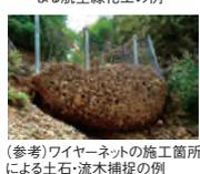
(参考)ワイヤーネットの施工箇所による土石・流木捕捉の例
