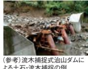
(参考)流木捕捉式治山ダムによる土石・流木捕捉の例
