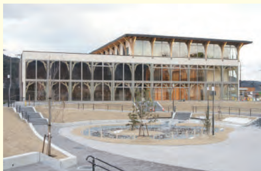
正面側の連続門型アーチ架構
