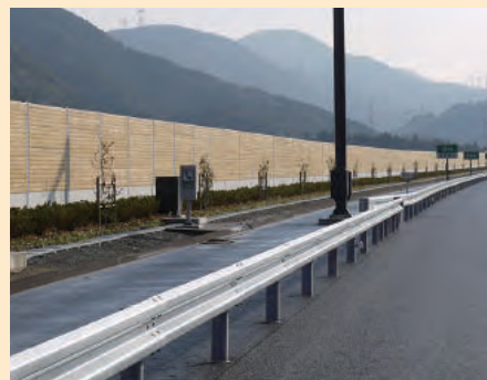
新東名高速道路 木製遮音壁
