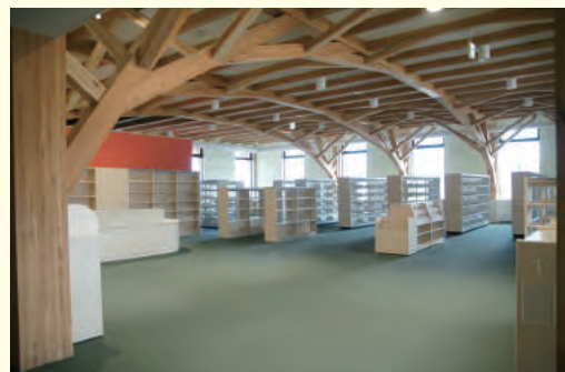
図書館の樹状方杖架構
