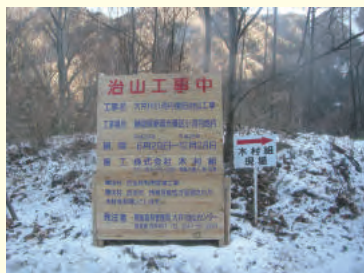
木製の工事看板
