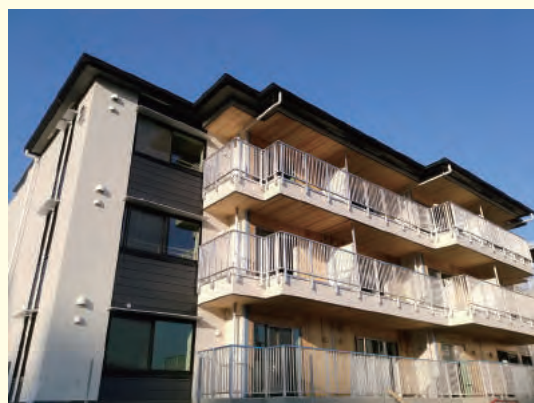
CLTパネル工法により建設された復興公営住宅
