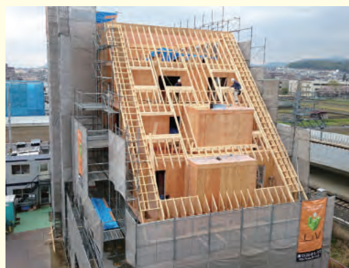
施工中の様子
