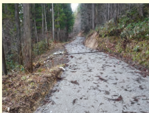
民有林に接続する作業道を開設
