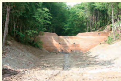
完成した治山ダム
