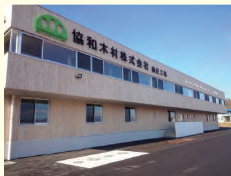
外装に1時間準耐火の外壁用木製集成材(WOOD.ALC)を使用した管理棟
