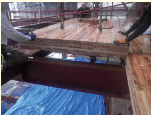
事務所棟のCLT床の施工の様子
