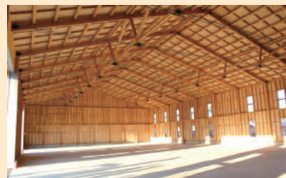
熊本県熊本市 肥後木材（株）倉庫
