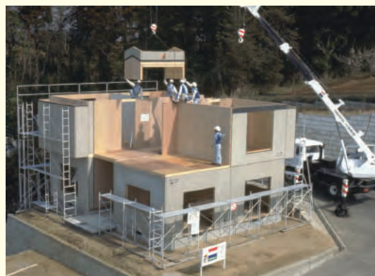
建設中の木質プレハブ住宅
