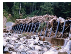
流木捕捉式治山ダムの設置
