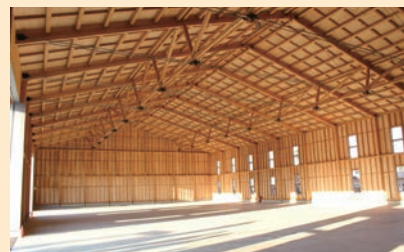
熊本県熊本市 肥後木材（株）倉庫
