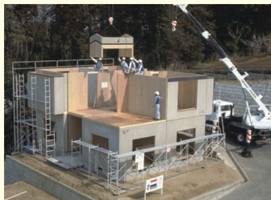
建設中の木質プレハブ住宅
