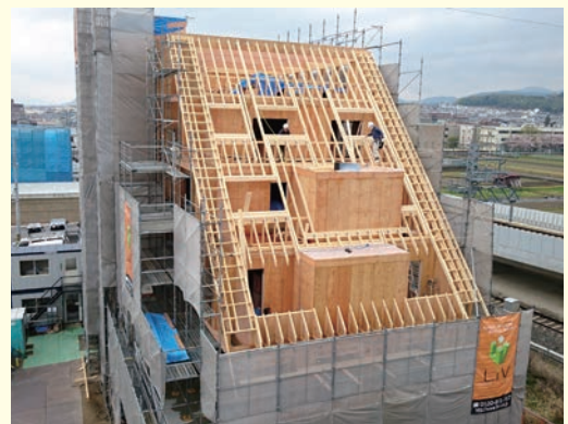
施工中の様子
