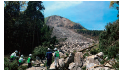
平成28年熊本地震による林地被害に関する林野庁九州森林管理局の現地調査
