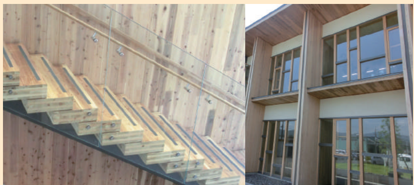
CLTを活用した木造建築の内装(左)と外観(右)(高知県南国市)
