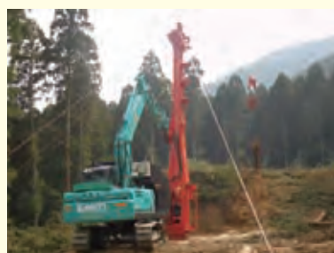
開発されたタワーヤーダ
