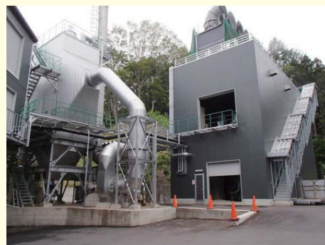
発電施設の外観
