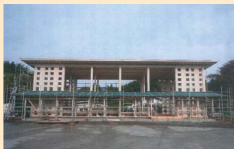
事務所棟(福島県いわき市)
