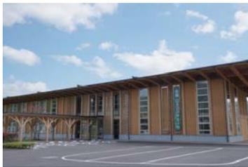
・岩手県気仙郡住田町の木造の新庁舎(写真)は、町内産のスギ・カラマツを使用。柱・梁は燃えしる設計による集成材で準耐火構造としたほか、耐震性を高めるため木材を格子状に組んだ「ラチス耐力壁」を国内で初めて採用。
