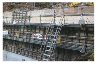
山形森林管理署では、平成26(2014)年度の治山 工事(コンクリート谷止工)において、国産カラマツ の間伐材を活用したコンクリート型枠用合板約200 枚による試験施工を実施。従来の南洋材型枠用合板 と比べて遜色ない性能・施工性が確認。
